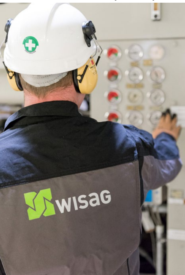
Bedienung der Kraftwerkanlagen. Foto: WISAG
